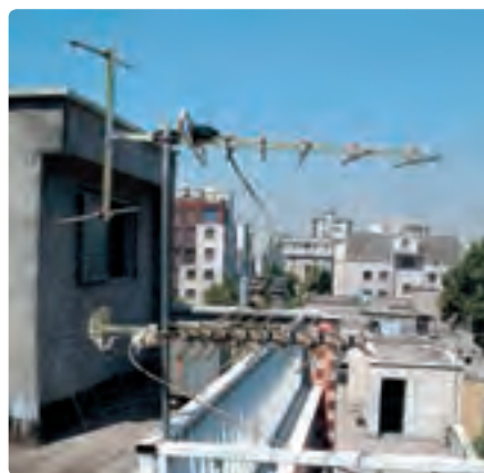
شکل ۱۸-۴ آنتن VHF و UHF روی دکل
