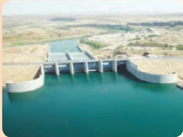
سد کرخه، بزرگ‌ترین سد خاکی - رسی خاورمیانه
