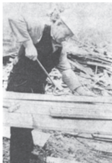
شکل ۱-۳۰ - میخ‌کشی از تخته توسط میخ‌کش اهرمی
