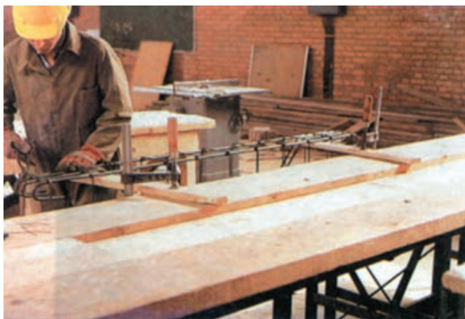
شکل ۲-۹۷- مونتاز میل‌گرد با استفاده از تخته‌هایی که با پیچ‌دستی به میز متصل شده‌اند.
