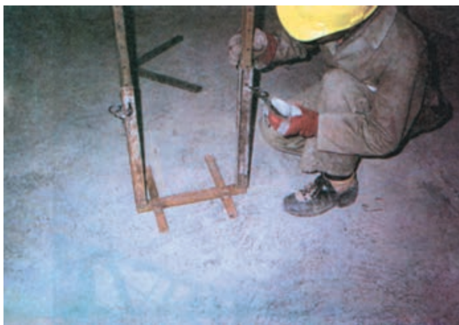
شکل ۹۵-۲- خرک قابل تنظیم برای ارتفاع های متفاوت
