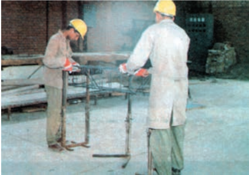
شکل ۱۲-۳- طریقه‌ی مونتاژ آرماتورهای یک پوتر کوچک
