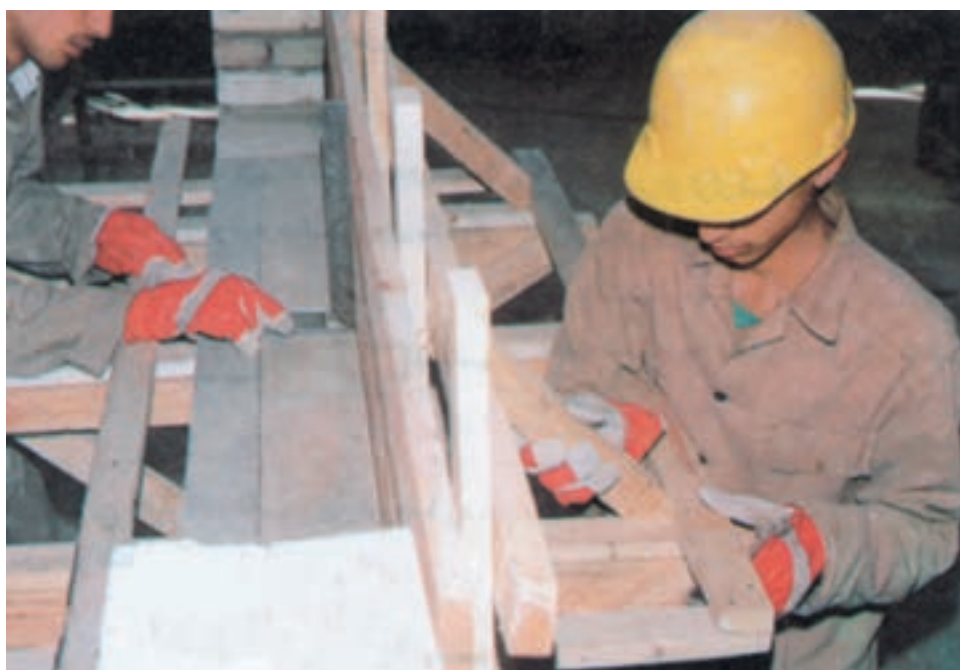
شکل ۱۱-۳- نصب گونه، گونیاکردن و نصب دستک‌ها
