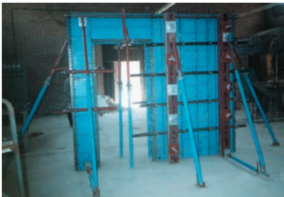
شکل ۲۹-۸ - قالب تکمیل شده دیوار و ستون بتنی
