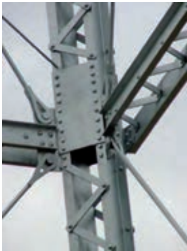
شکل ۳-۱ کاربرد پیچ اتصال
