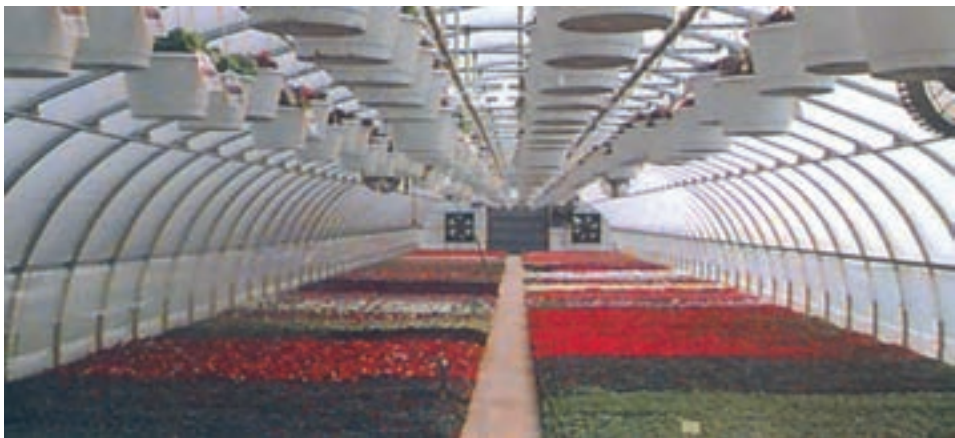
شکل ۱۱-۶- سیستم پوشال و پنکه در انتهای گلخانه نصب گردیده است.
