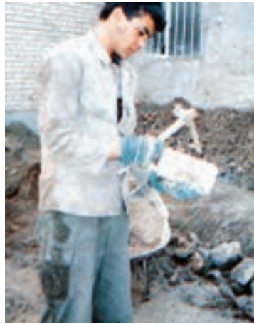
شکستن آجر به روش درست
