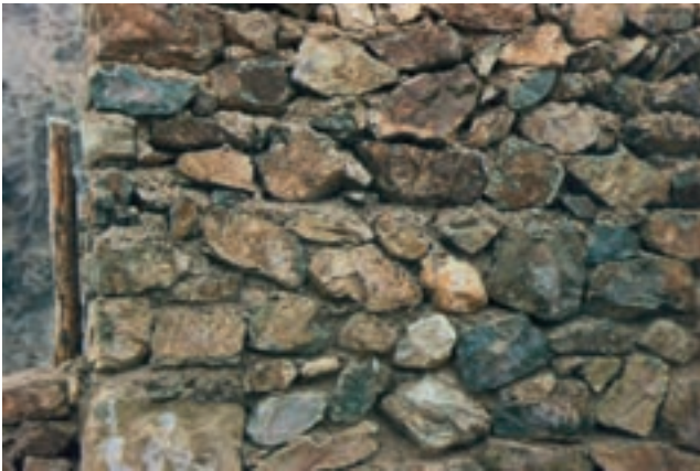
شکل ۶-۲۰- نمایش دیوار لاشه‌چینی با ملات
