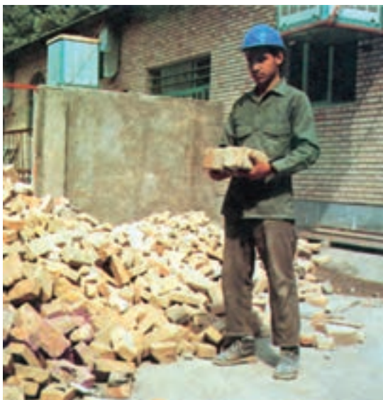
شکل ۱۲-۱۹- طریقه‌ی برداشتن و به‌دست گرفتن چند آجر
