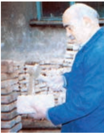
شکستن آجر به روش غلط
