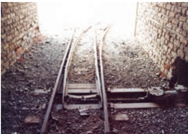
شکل ۱۱- ۳۱- انواع خطگردان و انشعاب خطوط ریل
