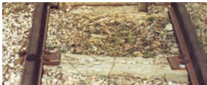
شکل ۳-۳۱- اتصال ریل به تراورس چوبی
