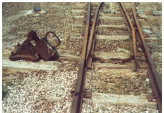
شکل ۱۱- ۳۱- انواع خطگردان و انشعاب خطوط ریل
