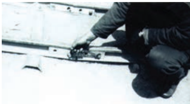
شکل ۵-۳۱ کارگر در حال بستن بغل‌بند
