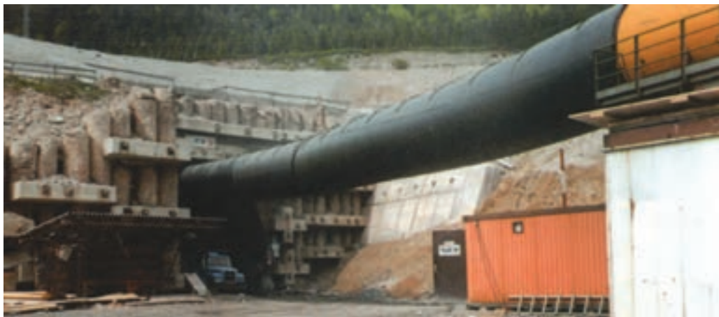
شکل ۱۳-۹- آویز جهت نصب لوله‌های تهویه
