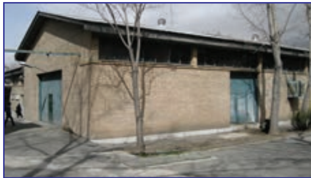
شکل ۱-۳- ساختمان قسمتی از کارخانه
