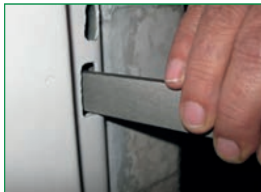
شکل ۱-۴- سوهان کاری سوراخ چهارچوب درب
