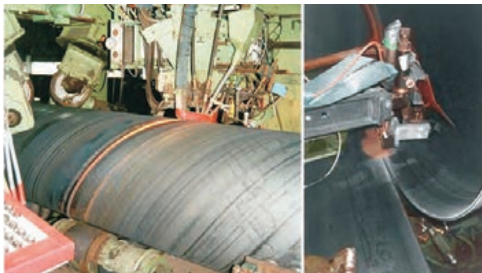
شکل ۴-۲۵- ب جوشکاری خارج لوله
