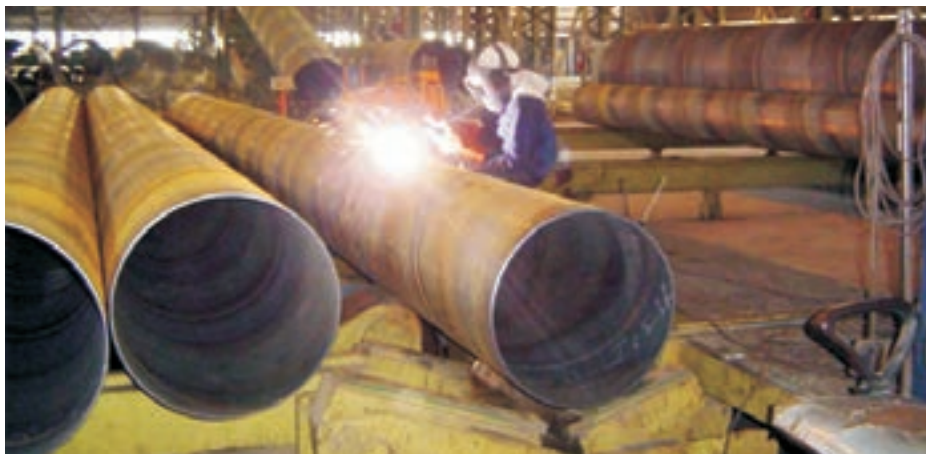
شکل ۴-۳۱ تعمیر لوله‌های معیوب
