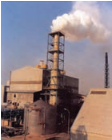
شکل ۲۶-۷- گازهای خروجی از دودکش در خوردگی تجهیزات اطراف واحد صنعتی مؤثر است.
