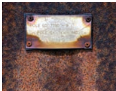
شکل ۷-۱۰- تشکیل پیل گالوانیک به دلیل نصب پلاک و قفل از جنس آلیاژ مس روی ستون فولاد کربنی
