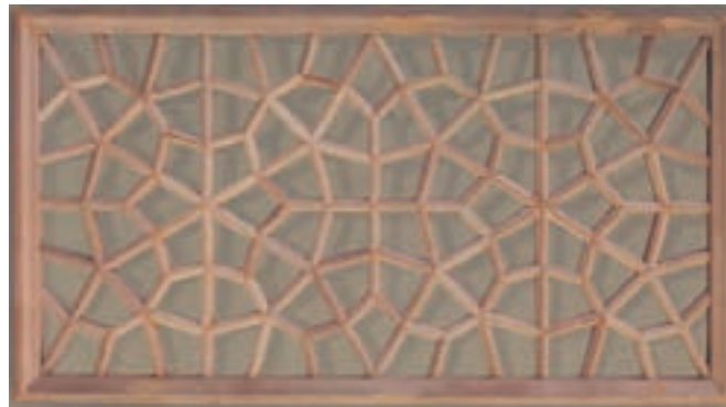
شکل ۹-۸۸- اتصال متقاطع در گره چینی یک پنجره.
