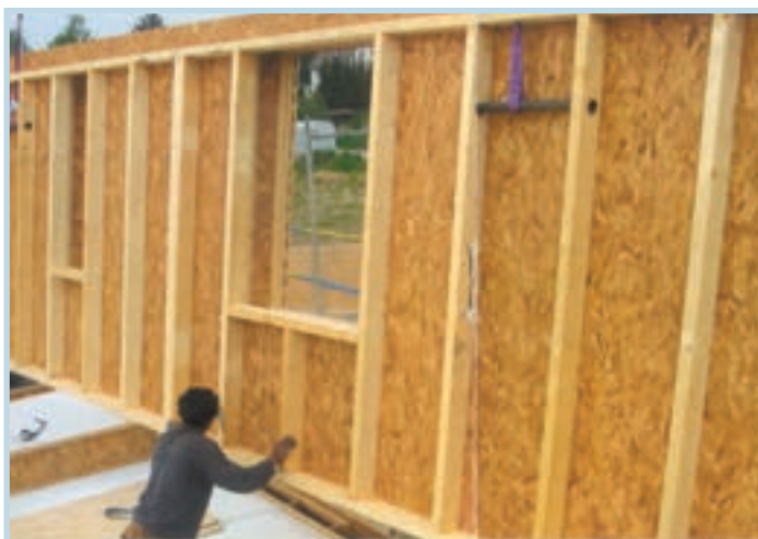
شکل ۴-۱- دیوار پیش ساخته چوبی در حین نصب
