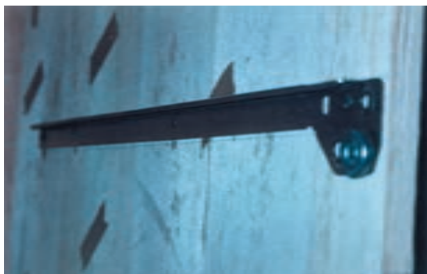
شکل ۳۱- نصب ریل روی بدنه
