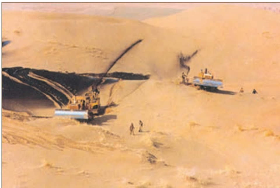
شکل ۱۱-۳- پاشیدن مالچ نفتی بر روی ماسه‌های روان
