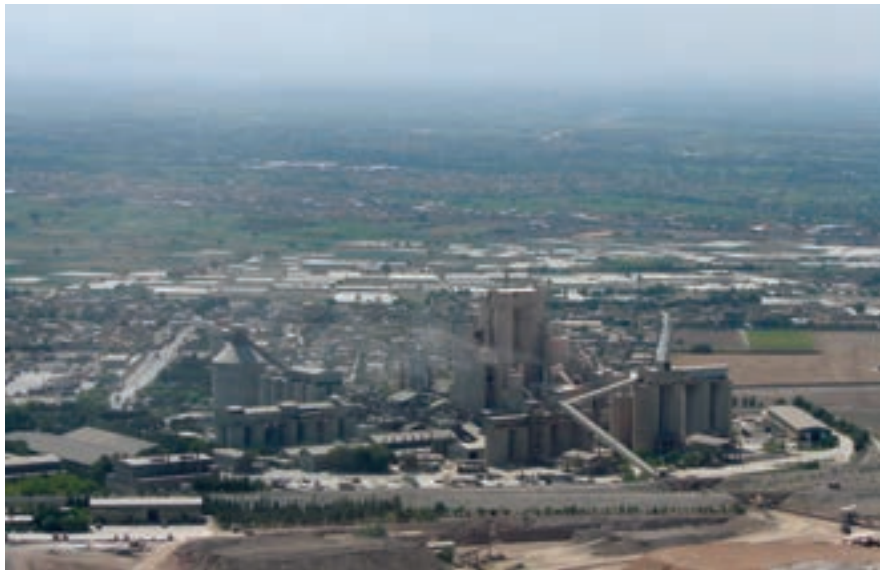
شکل ۳۹-۳ کارخانه سیمان در داخل محدوده مسکونی اصفهان
