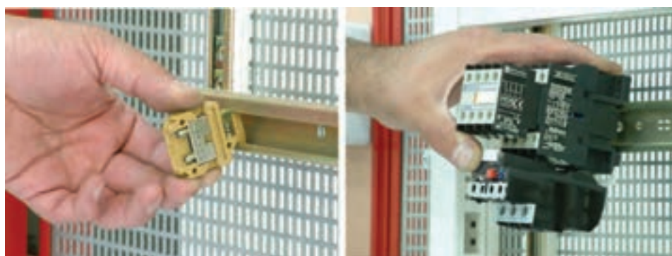
شکل ۶۷-۵- نصب کنتاکتور و ترمینال روی ریل
