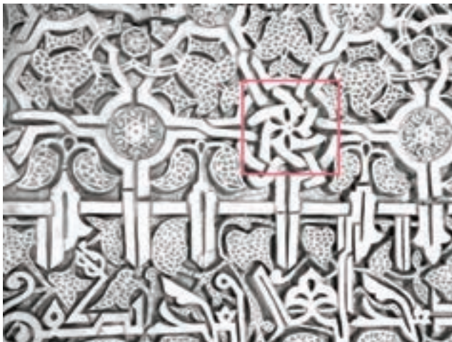
شکل ۳۳-۶. بخشی از گجبری مسجدی در ارومیه
