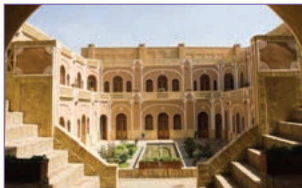
تصویر یک خانه قدیمی بازسازی شده در یزد
