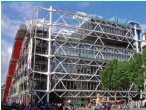
مرکز فرهنگی ژرژ پمپیدو در پاریس، تأکید بر سازه و تأسیسات در بنا، یعنی عامل اصلی مؤثر بر طراحی
