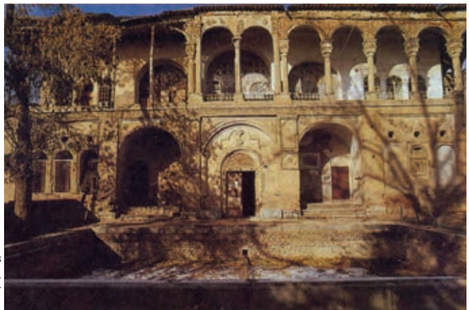
تصویر ۱۴-۵- نمای درونی یک خانه مسکونی سنتی در مناطق کوهستانی نشان داده شده است.
