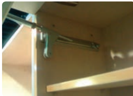
شکل ۶-۳۷ در کابینت نصب شده با نگهدارنده پمپی
