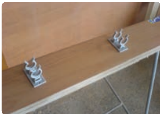
شکل ۶-۶۵ اتصال کلیس پاسنگ به پایه کابینت
