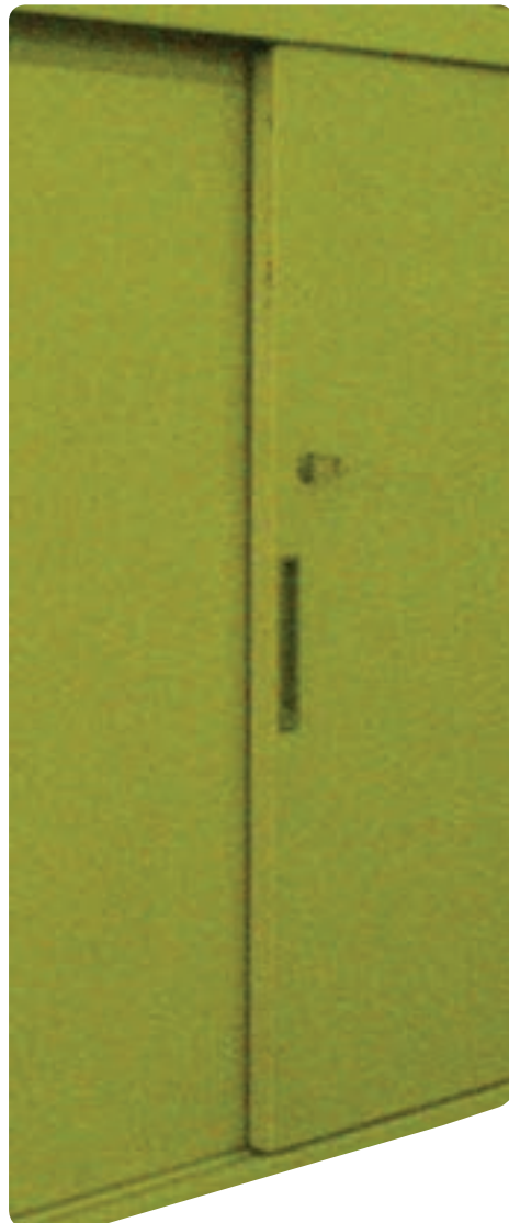
شکل ۶-۳۰: در کشویی با دستگیره توکار
