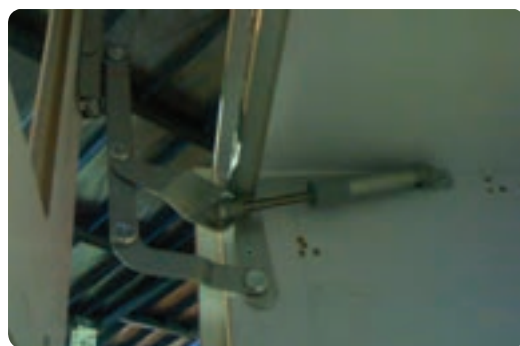
شکل ۶-۳۸ در کابینت نصب شده با جک اتوبوسی
