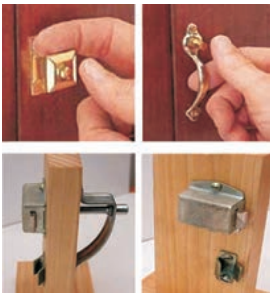
شکل ۷-۴۳ شب بند بدون فنر
