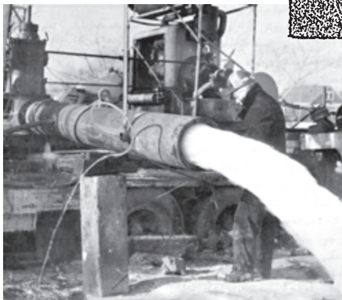
شکل ۵-۶- چاه آب با ظرفیت آب‌دهی ۳۰۰۰ گالن در دقیقه، آب چاه کاملاً صاف و بدون شن است.
