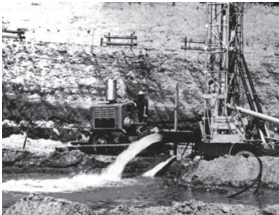
شکل ۷-۵- چاه عمیق با عمق بیش از ۳۰۰ متر
