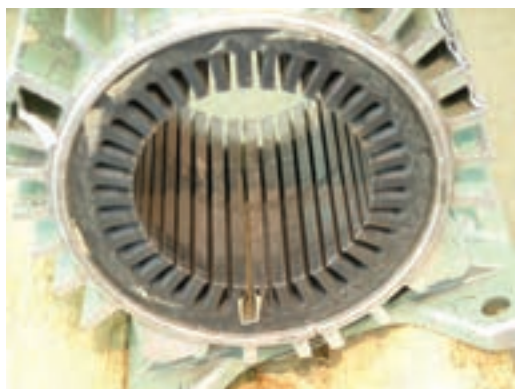
شکل ۲-۳۶- آزمایش عایق در داخل شیار
