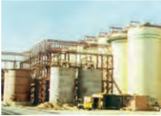
شکل ۱-۳۹- تأسیسات نفتی در جنوب
