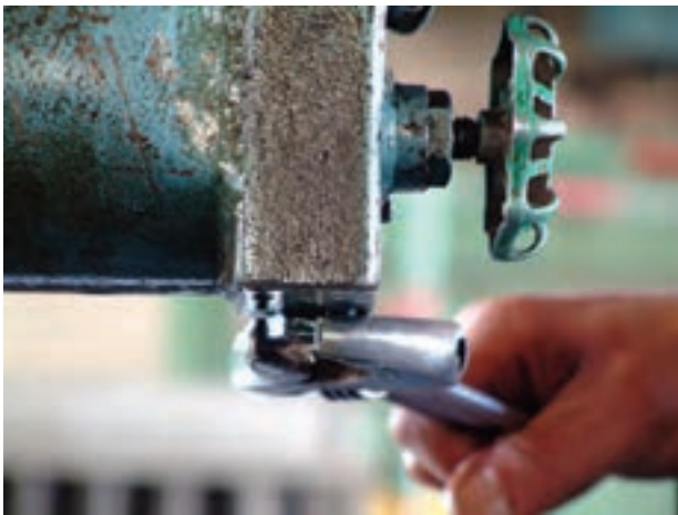
شکل ۱۴-۳- باز کردن درپوش تخلیه‌ی روغن
