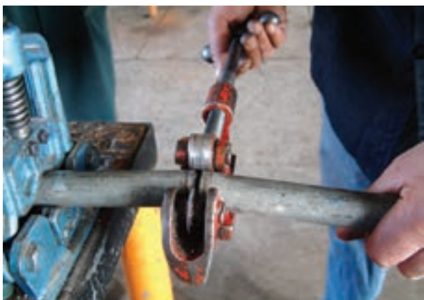
شکل ۳-۵۲- بریدن لوله‌ی محاسبه شده
