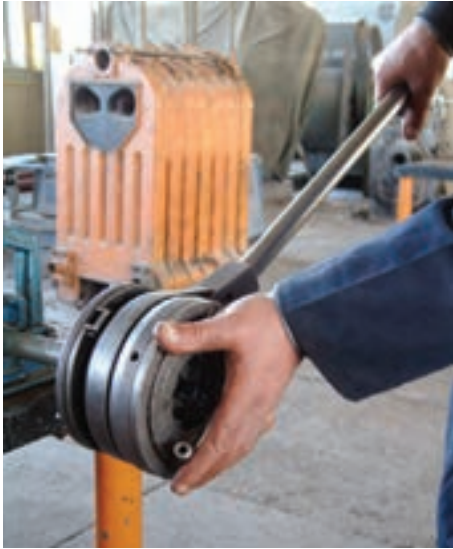
شکل ۴-۶۶- درگیر کردن حدیده با سر لوله
