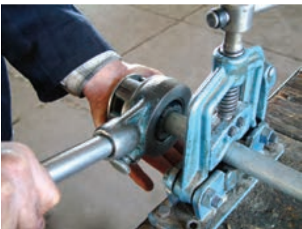
شکل ۴-۴۷- شروع دنده کردن لوله
