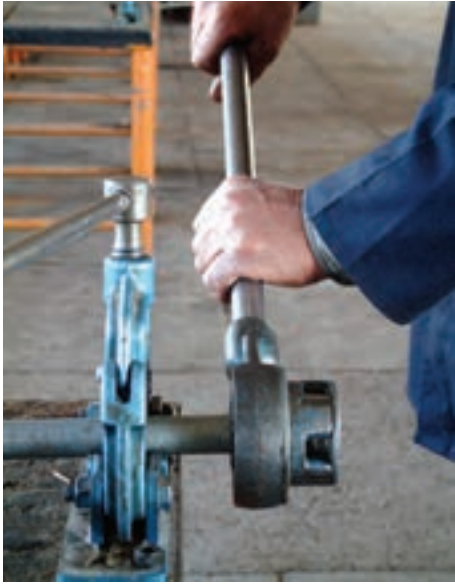
شکل ۴-۴۸- عمل حدیده کاری
