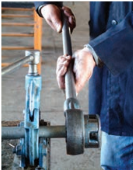
شکل ۴-۵۰- باز کردن حدیده از لوله
