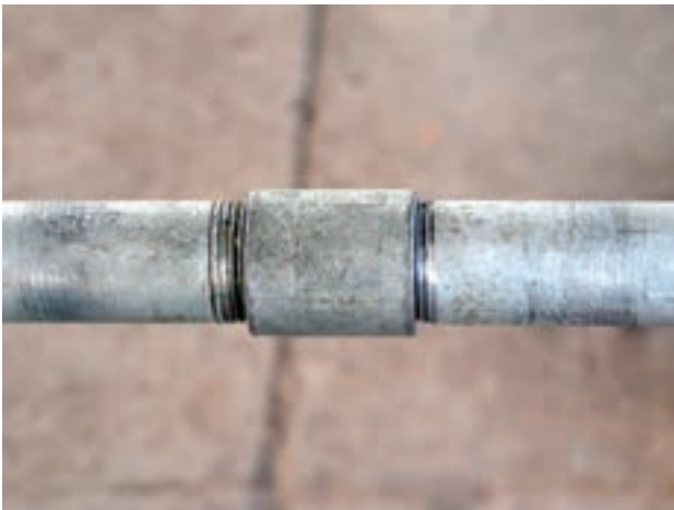
شکل ۳-۵- اتصال دنده‌ای
