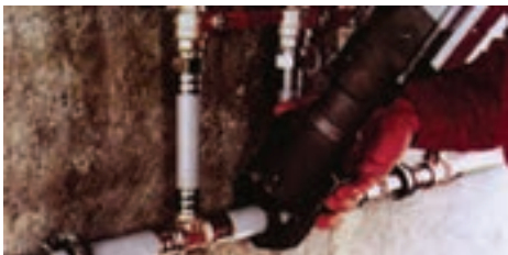
شکل ۲۳-۵ - اتصال پرسی
