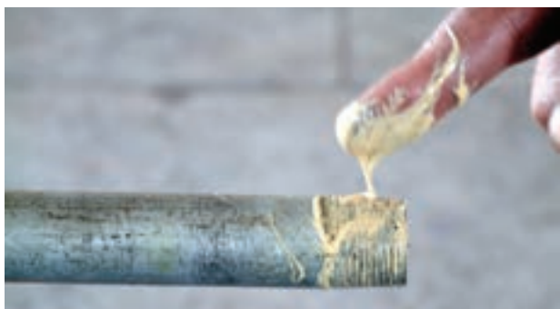
شکل ۵-۵۳- مالیدن خمیر بر روی سردنده
