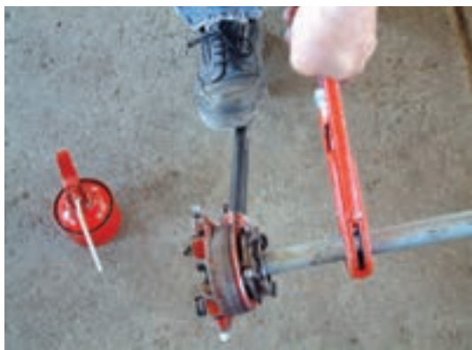
شکل ۱۲۰-۵- عمل حدیده کاری لوله
