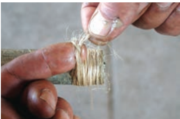
شکل ۵-۵۵- گره زدن انتهای پیچیدن کنف
