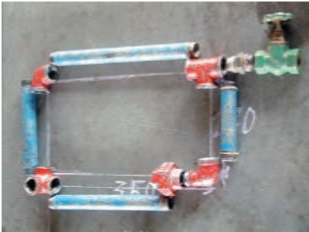
شکل ۱۱۴-۵- قرار دادن لوله‌های حدیده شده در محل خود و کنترل نمودن صحت انجام کار
