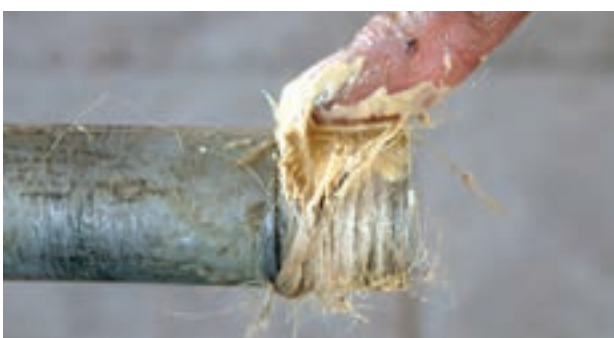
شکل ۵-۵۷- مالیدن خمیر آب بندی بر روی کنف
