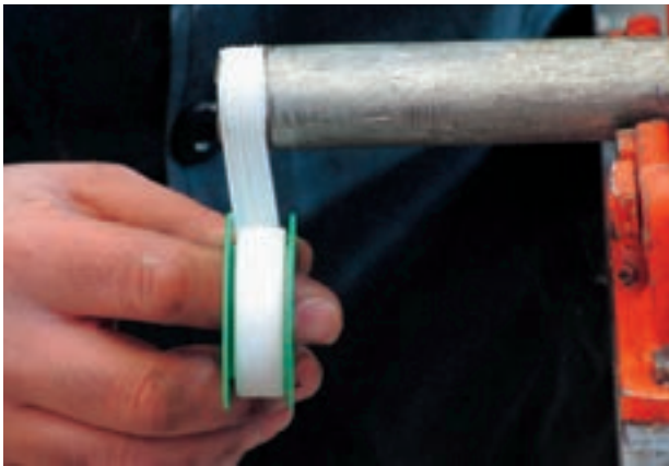
شکل ۵-۵۸- نحوه‌ی پیچیدن نوار تفلون بر روی سردنده
