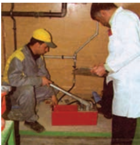
شکل ۵-۹۳- نحوه‌ی آزمایش با پمپ آزمایش دستی
