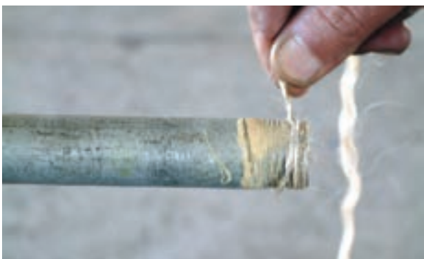
شکل ۵-۵۴- پیچیدن کنف بر روی سردنده
