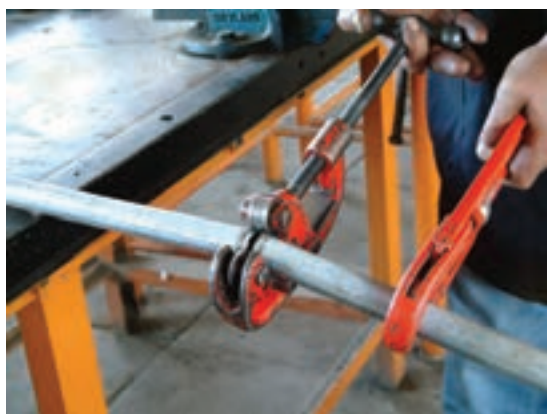
شکل ۱۱۷-۵- بریده شدن لوله و خاتمه‌ی کار
