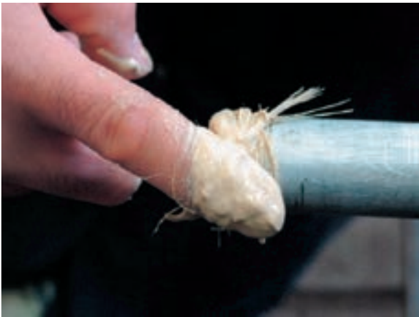
شکل ۹۰-۵- خمیر و کنف کردن سردنده
