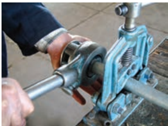
شکل ۱۵۱-۵- حديدہ کردن لوله‌ها
