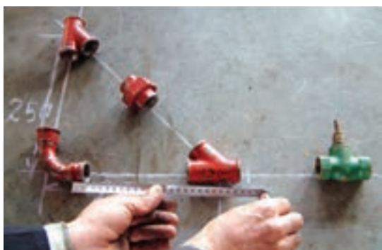
شکل ۱۳۴-۵- اندازه‌گیری لوله‌های مورد نیاز
