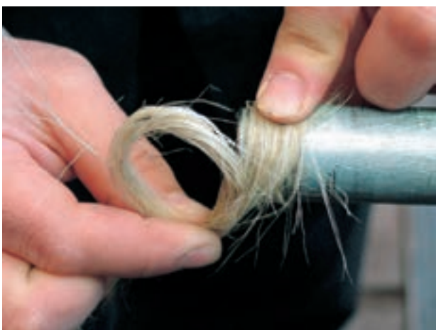
شکل ۱۳۸-۵- پیچیدن مواد آب‌بندی به سردنده‌ها
