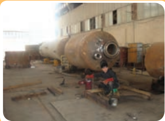
ب) کارگاه ساخت مخازن تحت فشار
