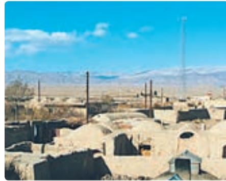
شکل ۴۱-۲- سقف خانه‌ها در مناطق گرم - سمنان
