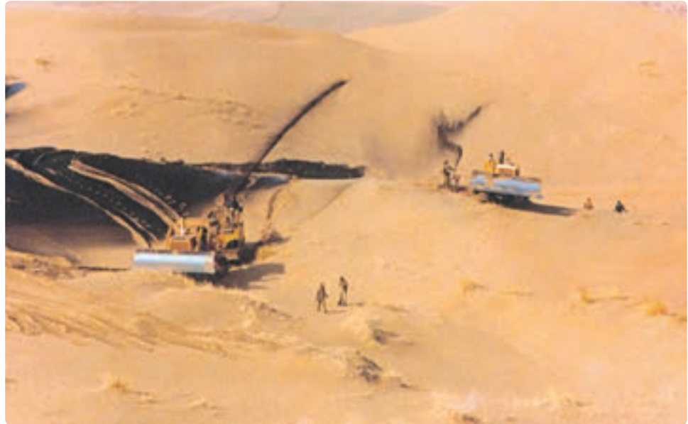
شکل ۹-۳- پاشیدن مالچ نفتی بر روی ماسه های روان
