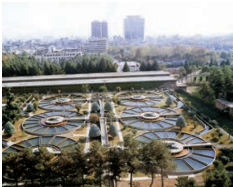
شکل ۱۲-۹- تصفیه خانه شماره ۲ آب تهران - جلالیه
