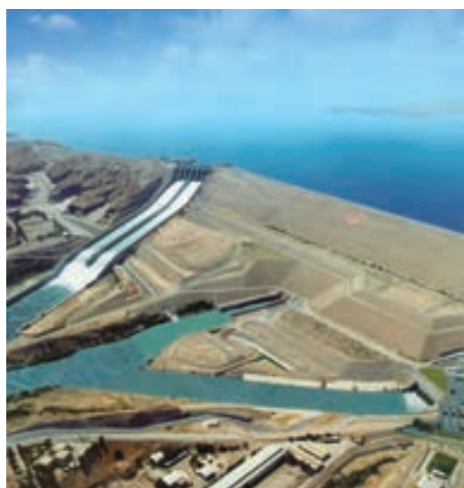
شکل ۱۰-۹- سد و نیروگاه آبی کرخه، شیوه ای نو برای بهره برداری از آب های سطحی
