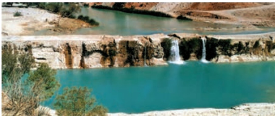
شکل ۸-۹- بند بهمن در استان فارس از ابداعات ایرانیان برای بهره گیری از آب های سطحی (زمان تقریبی ساخت ۲۰۰۰ سال قبل)
