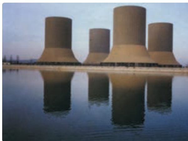
شکل ۱۴-۹- استفاده مجدد از آب مصرفی در نیروگاه‌ها (نیروگاه شهید رجایی - قزوین)
