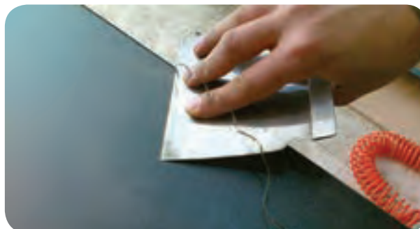
شکل ۲۵-۴ - نحوه برطرف کردن اضافه نوار با لیسسه
