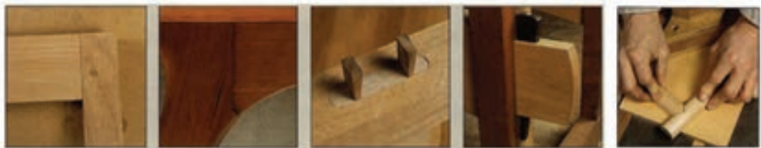
اتصال میانی آلت چینی اتصال گوه ای اتصال میانی با گوه فاق و زبانه با دوبل شکل (۳-۵) موارد ۱ تا ۵
