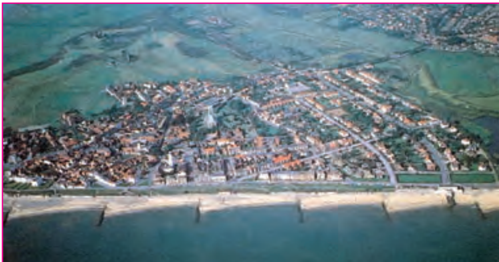
شکل ۷- احداث حفاظ در سواحل ماسه‌ای
