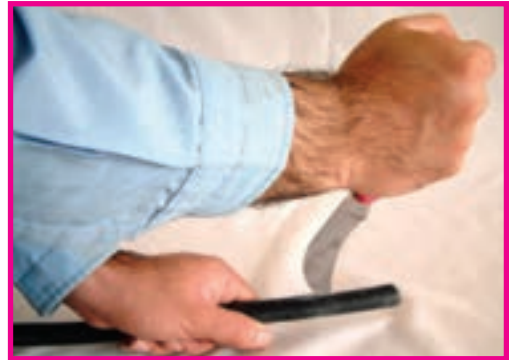
شکل ۳-۴- طریقه صحیح روکش برداری کابل
