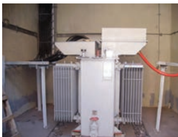
الف) ترانسفورماتور با جعبه ترمینال
