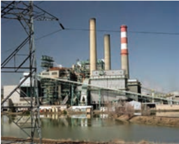
شکل ۲- نمایی از یک نیروگاه گازی ۱
