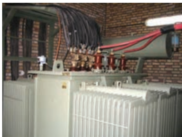
ب) ترانسفورماتور بدون جعبه ترمینال
