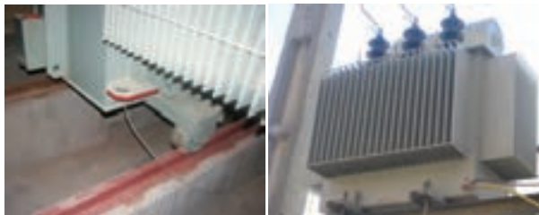
شکل ۳۳- محل اتصال سیم زمین
