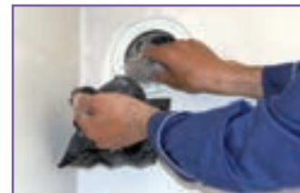
پ - برای خروجی دودکش هر دستگاه گاز سوز یک کلاهک H نصب شود. در پیچه های تأمین هوای ساختمان دست کم فاصله بین دودکش تا کولر آبی و یا سه متر باشد.
