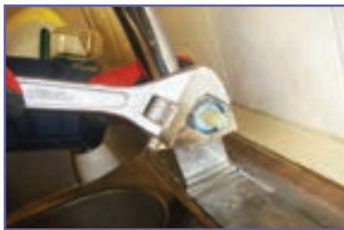
ث- باز کردن پیچ روی مغزی (گلند)
