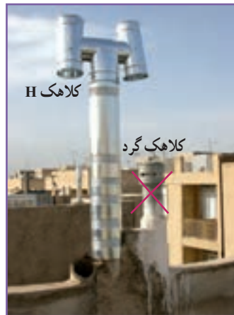
پ - برای خروجی دودکش هر دستگاه گاز سوز یک کلاهک H نصب شود. در پیچه های تأمین هوای ساختمان دست کم فاصله بین دودکش تا کولر آبی و یا سه متر باشد.
