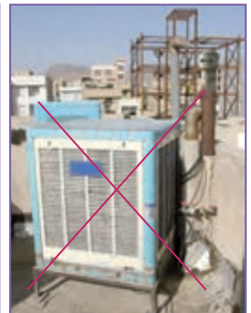
پ - برای خروجی دودکش هر دستگاه گاز سوز یک کلاهک H نصب شود. در پیچه های تأمین هوای ساختمان دست کم فاصله بین دودکش تا کولر آبی و یا سه متر باشد.
