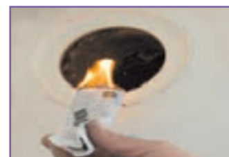
ج - قبل از راه اندازی دستگاه گازسوز از باز بودن مسیر دود در دودکش اطمینان حاصل کنید.
