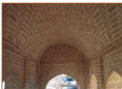
ب- استفاده از آجر برای سقف قوسی
