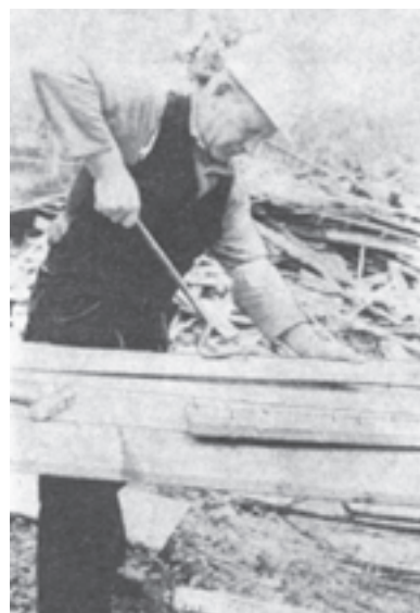
شکل ۳۰-۱- میخ‌کشی از تخته توسط میخ‌کش اهرمی
