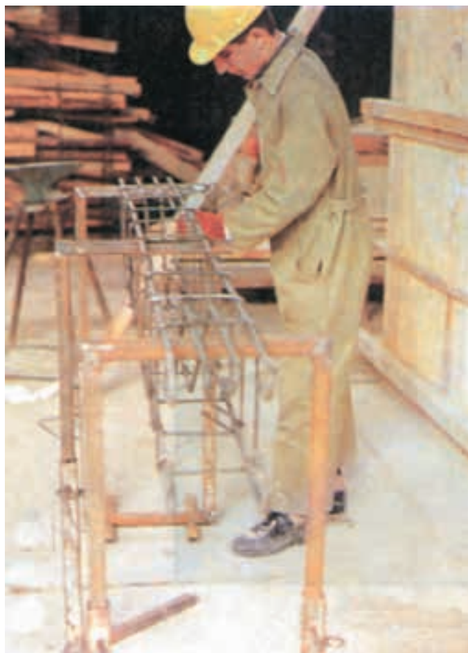
شکل ۲-۹۶- مونتاز میل‌گرد با استفاده از خرک فلزی متحرک
