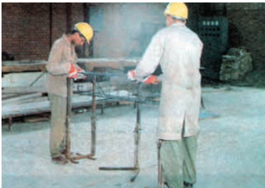
شکل ۱۲-۳- طریقه‌ی مونتاژ آرماتورهای یک پوتر کوچک
