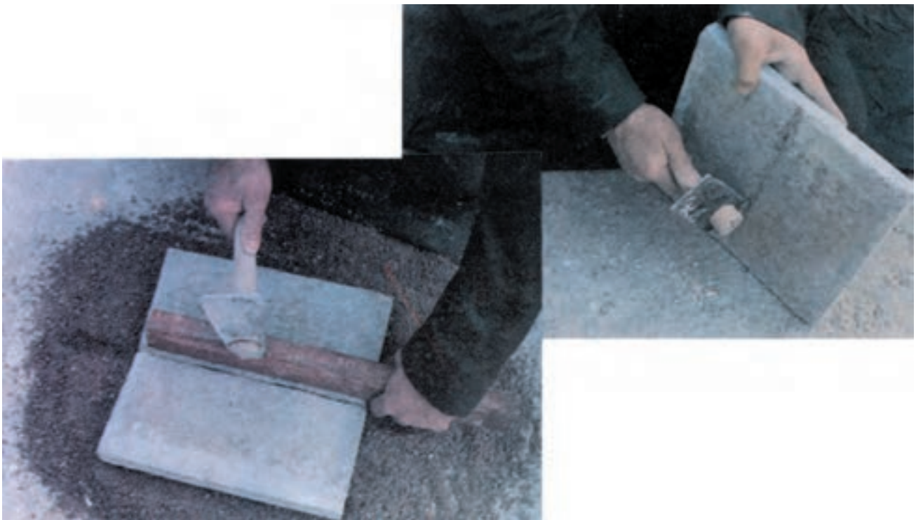
شکل ۵-۹- شیار و گودسازی پشت موزاییک به وسیله‌ی تیشه‌ی دو سر
