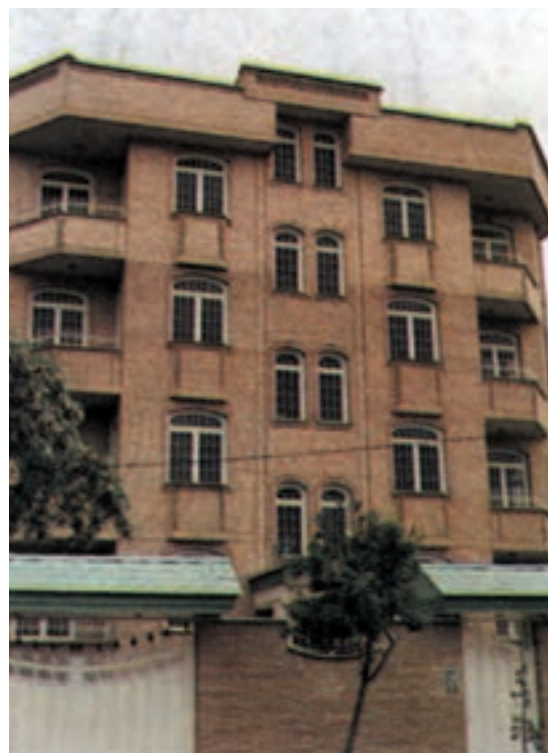
شکل ۶-۱- اجرای قوس در نمای آجری
